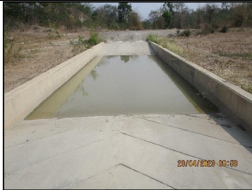
ภาพที่ 3.38 บ่อล้างล้อรถบรรทุก
