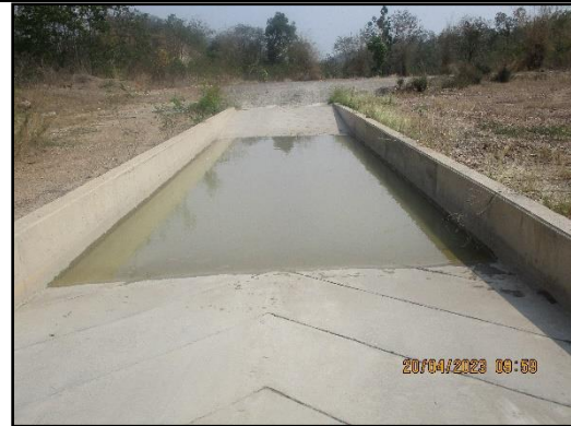
ภาพที่ 3.38 บ่อล้างล้อรถบรรทุก
