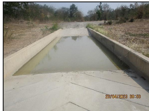
ภาพที่ 2.27 บ่อล้างล้อรถบรรทุก
